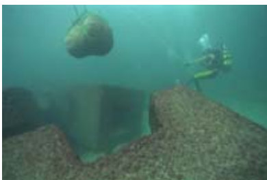
Blocs de béton servant de brise-lame
