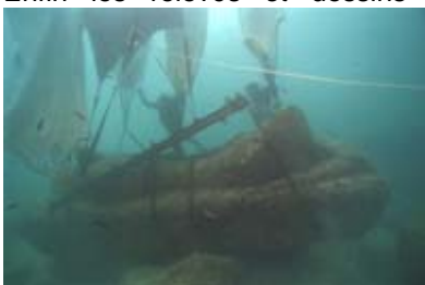
Déplacement de blocs à l'aide de ballons
